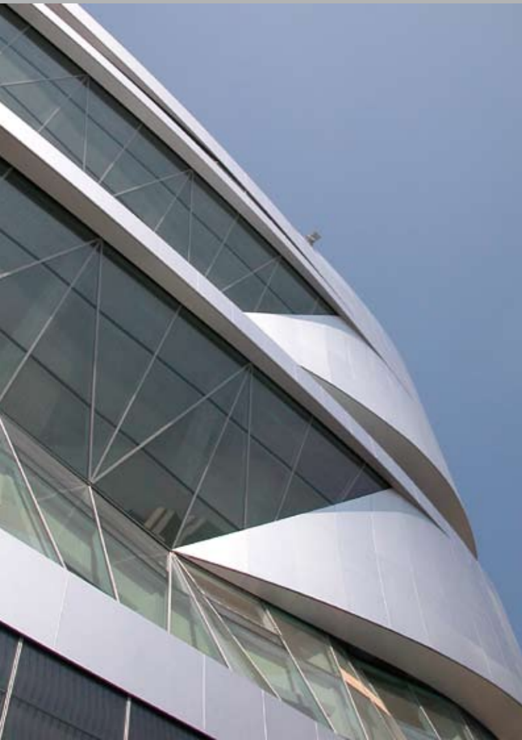
Mit moderner 3D-Technologie sind fast sämtliche geometrischen Konturen als Aluminiumvorhangfassade realisierbar.
